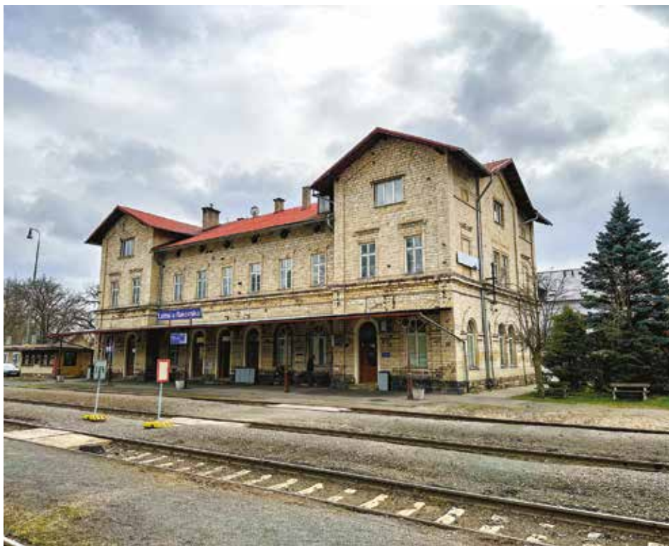
Obr. 11. Lužná u Rakovníka, výpravní budova, pohled od dráhy. Realizace projektu 4. třídy, která je výjimečná použitím kamenného, neomítaného zdiva. Foto: Eva Dvořáková, 2024.
