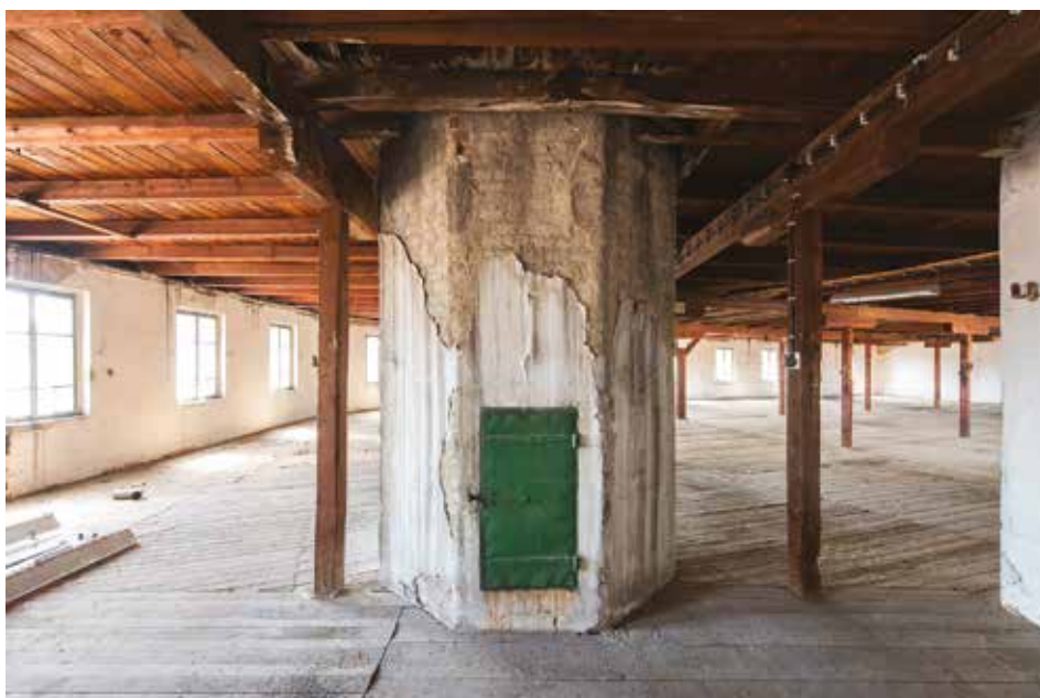
Obr. 9. Podstřešní část podstavce ve 4. nadzemním podlaží čp. 1148, uzavřená dvířka patrně vedla k nějakému typu roštu v průduchu komína. Foto: Martin Vonka, 2022.
