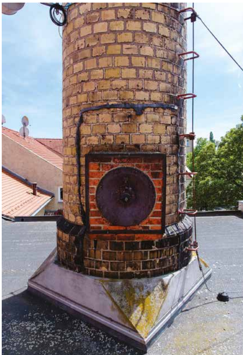
Obr. 14. Pozůstatky pohonného mechanismu ventilátoru v čp. 1950. Foto: Martin Vonka, 2022.
