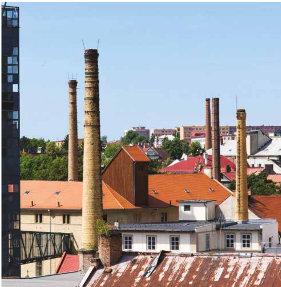
Obr. 3. Část dochovaného komínového fondu. Komíny oktogonální i oblé. Oktogonální komín v pozadí má snesenou hlavici. Oblý komín vpravo vznikl výstavbou nového dříku na starší podstavec. Zcela v popředí je patrné torzo oktogonálního komína. Foto: Martin Vonka, 2022.
