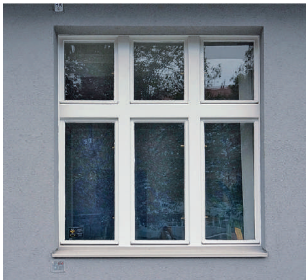
Obr. 2. Šestikřídlé okno (č. 1), 1930, nájemní dům, Praha-Dejvice. Foto: Alexander Kuric, 2020.
