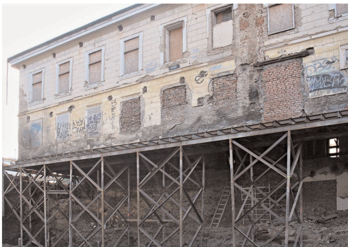
Obr. 7. Vršovický zámek během rekonstrukce a dostavby, pohled od severu, v levé části místo budoucího napojení nového východního křídla. Budova v té chvíli stála na ocelové konstrukci. Foto: Masák & Partner, 2010.
