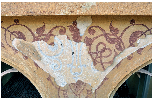
Obr. 9. Minaret, detail fasády před obnovou s odhaleným původním dekorem basreliéfu. Foto: Martin Pácal, 2018.
