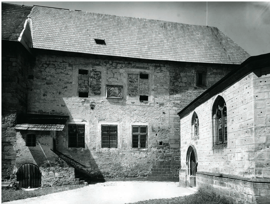
Obr. 11. Hrad Kost, fasáda středověkého paláce při hlavním nádvoří před rekonstrukcí okenních ostění, počátek 50. let 20. století. Foto: Věra Pospíšilová, NPÚ, GmŘ.
