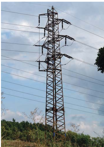
Obr. 17. Kotevní stožár s dvojicí ramen pro transpozice obou trojic vodičů linky 110 kV Toušeň – Kolín u Poříčian. Foto: Martin Boháč, 2016.
