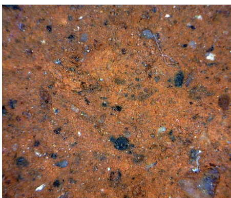
Obr. 3. Stav pálené dlažby před čistěním. Foto: Petr Kotlík, 2017.
