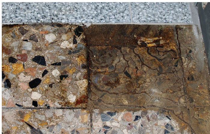
Obr. 8. Stav dlažby terrazzo před čištěním. Foto: Petr Kotlík, 2017.
