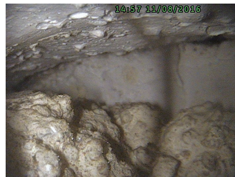
Obr. 15. Kunštát, zámek, nika okenního otvoru na západní stěně místnosti č. 303 – videoskopie středověkého záklenku. Foto: David Zeman, 2016.
