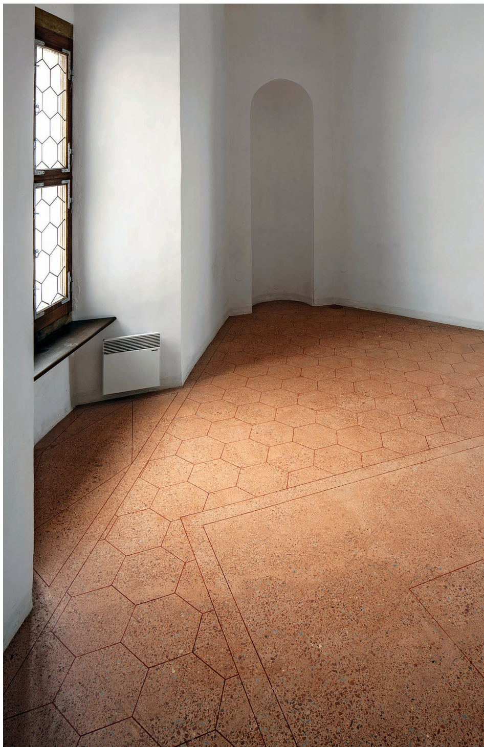
Obr. 3. Příklad renesanční maltové podlahy dochované a dosud používané v 1. nadzemním podlaží letohrádku Hvězda v Praze (dnes Památník národního písemnictví). Foto: Gabriela Čápková, 2015.
