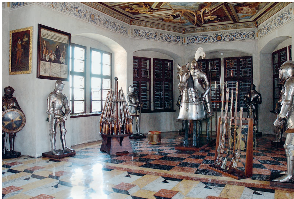
Obr. 2. Maltová, složitě barevně komponovaná podlaha tzv. Rytířského sálu SZ Telč imituje úpravu z mramoru. Příklad vizuálně velmi atraktivní maltové podlahy. Foto: Archiv SZ Telč.
