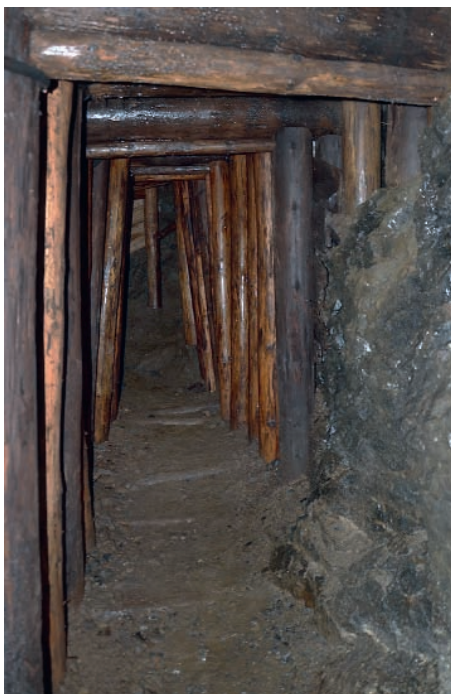
Obr. 12. Zlatý Kopec, důl Johannes. Vlevo ukázka dřevěné výztuže chodby, vpravo nově vybudované bráně (stvolu jámy) s lezným (vpředu) a těžným oddělením. Foto: Ondřej Malina, 2015.
