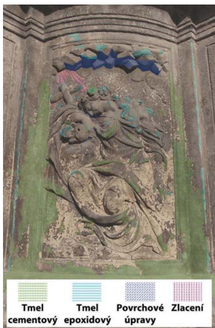
Obr. 4. Kutná Hora, Morový sloup, reliéf sv. Rozálie: grafický záznam poškození. Foto: Roman Kolář, 2014.
