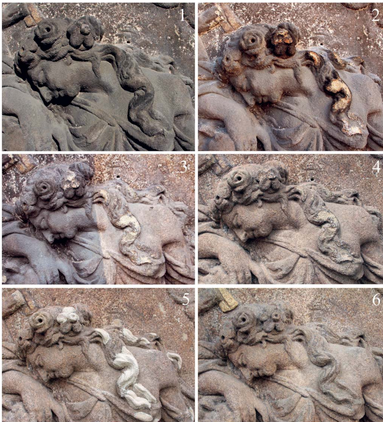
Obr. 10. Kutná Hora, Moravský sloup, reliéf sv. Rozálie, průběh prací (stav před restaurováním, po sejmutí tmelů a zpevnění, v průběhu čištění, po očištění, po doplnění a po restaurování). Foto: Roman Kolář, 2015.
