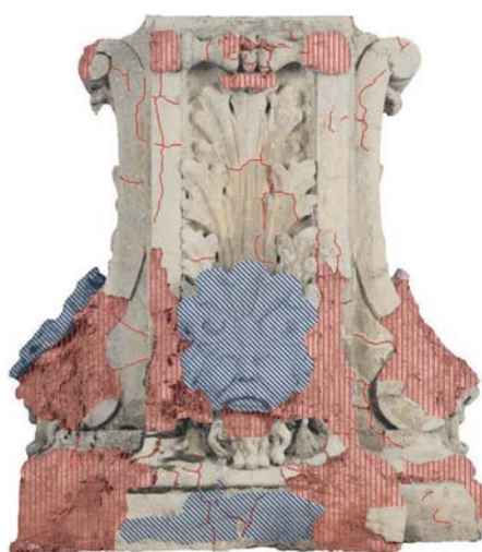
Obr. 5. Podstavec s maskarony, restaurátorská zpráva, zá- kres poškození, jižní strana (červené šrafy – chybějící části, modré šrafy – starší restaurátorské doplňky, červené čáry – praskliny). Foto: Lukáš Brotánek, 2013.
