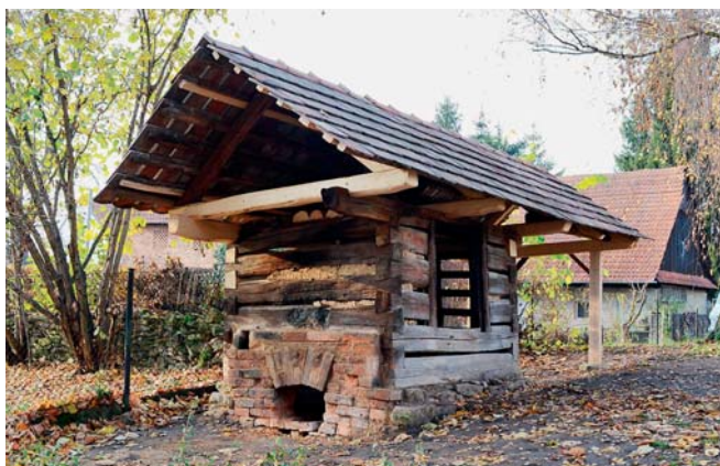
Obr. 5. Zálší (okres Ústí nad Orlicí), sušárna ovoce u č. p. 12. Objekt po opravě. Zachováno bylo i kladení bobrovek se spárami nad sebou. Foto David Stejskal, 2015.
