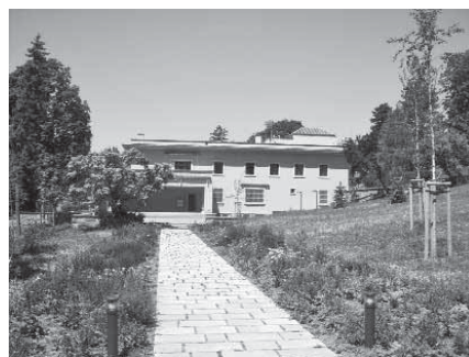
Obr. Východní průčelí vily Stiassni s obnoveným květinovým parterem z doby krátce po založení. (Foto: Roman Zámečník, 2015)
