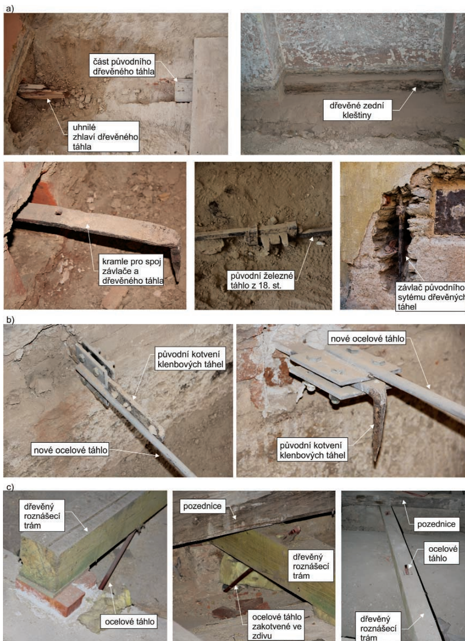
Obr. 4. Teplá (okres Cheb), klášter premonstrátů, konvent – a) historický systém dřevěných klenbových táhel a kleštín; b) napojení ocelových táhel provedených v rámci současně probíhající rekonstrukce na původní kotvení historických dřevěných klenbových táhel; c) kleštiny nad 2. NP provedené v rámci rekonstrukce v letech 2004–2008. (Foto: autoři článku, 2015)
