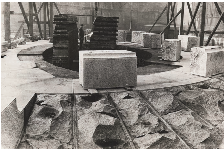
Obr. 10. Praha (MČ Praha 1), pohled na rozestavěný pomník. Na snímku jsou patrné žulové kvádry představující rozbouřenou hladinu; na horní podestě jsou pak připraveny bloky bosované žuly pro horní etáž podstavce. Ve středu jsou vidět podpůrné zdičky z pálených cihel. (Foto: Archiv hlavního města Prahy, 1913)
